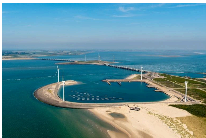
Image . Photo du Eastern Scheldt Barrier. Le plus grand barrage des Pays-Bas, construit dans le cadre du projet Delta, mesurant 9km.
